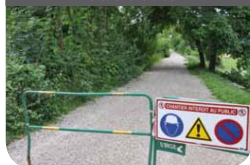
Voie cyclable le long du canal encore « en chantier »
